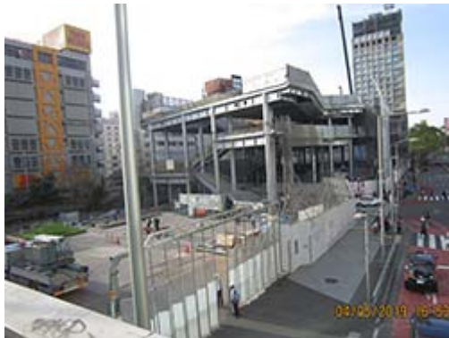
手前は道路上で南北をつなぐ巨大な歩道橋 奥に見える高い建物は18階建てのホテル
