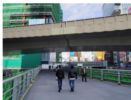
東口歩道橋の架け替え
